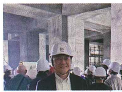
城北中央公園貯水池工事 現場視察
